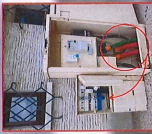
Fourreaux à déplacer dans le coffret à gauche lors du déplacement des coffrets
