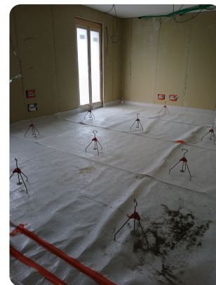
préparation de la chape
