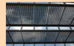
Bi-verre photovoltaïque laissant passer la lumière : solution intéressante en toiture de serre ou de véranda
