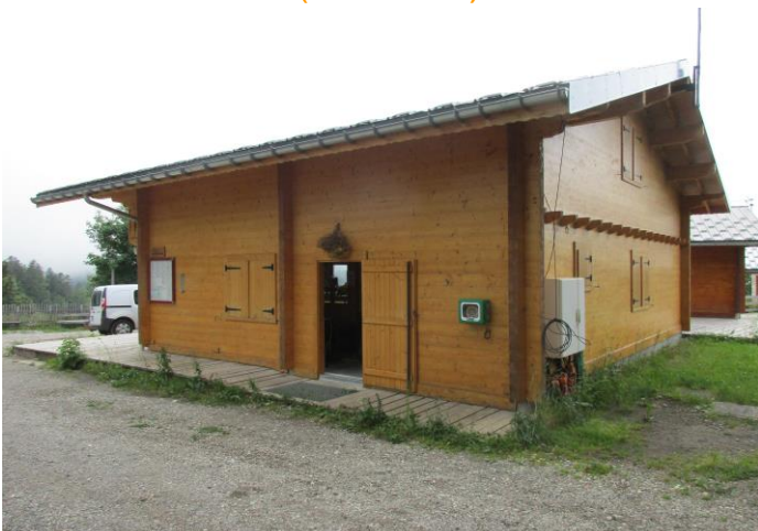
Caisses des remontées mécaniques (extérieur)
