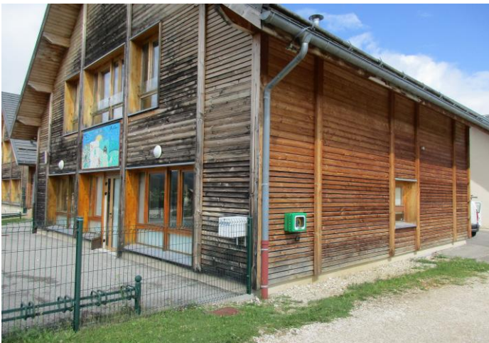
Groupe Scolaire (extérieur)
